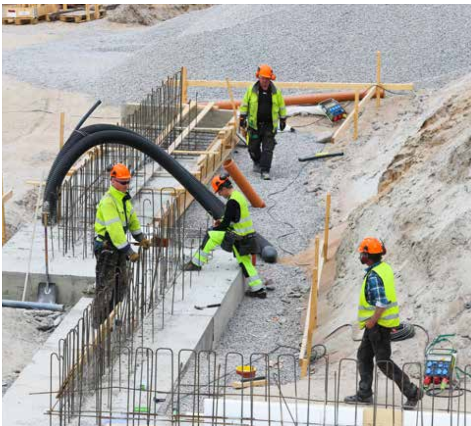
Stiftelsen Kalixbo startade i maj månad arbetet med sitt nästa stora byggprojekt i kvarteret Prästen. Hyreshusen kommer att ha fem våningar och består av 33 tvårummare och 16 trerummare
