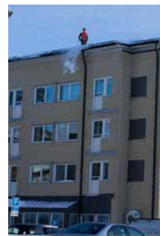
▲ Taket på det fem våningar höga äldreboendet Rönngården i centrala Kalix skottades i mitten av februari. Veckan senare hade det snöat och drivit och samma tak hade då, på vissa platser, ett snödjup på 160 centimeter.
