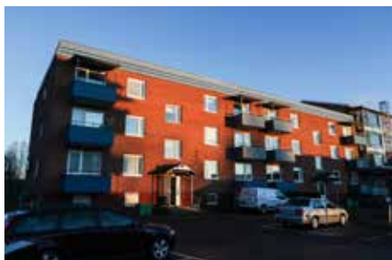
Den här fastigheten byggdes 1964 och nu kommer de 18 lägenheterna att renoveras från grunden.
