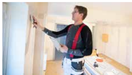
Det är en fröjd att se en skicklig målare spackla en vägg. Här är det ett av rummen på äldreboendet Hemgården i Töre som får nya ytskikt.
